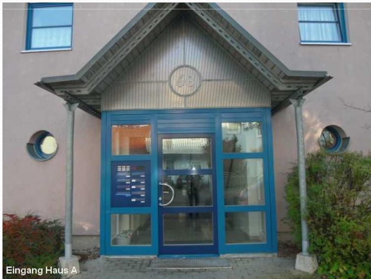
Wohnanlage Haus A
